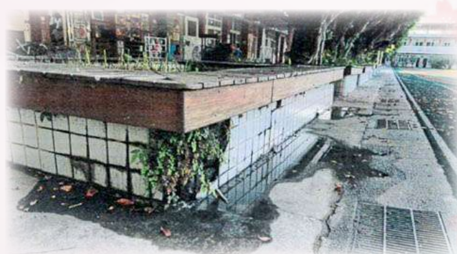
預計移除破裂生態池
